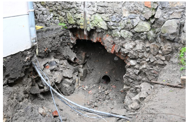
Zeugnis früher Stadttechnik: Mittelalterlicher Kanal in der Entenbachgasse. STADT FELDKIRCH
